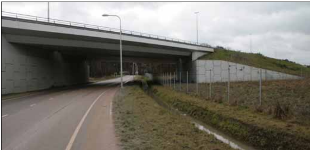
Figuur 5.4 Onderdoorgangen van viaducten kunnen worden geoptimaliseerd voor passage door fauna door een strook niet te verhard en deze te voorzien van bijvoorbeeld stobbenwallen; de doorgetrokken sloot is van belang voor watergebonden fauna.
