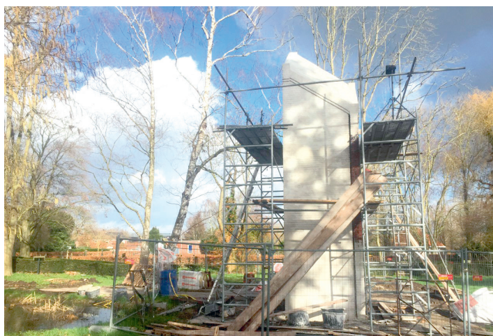
► De vleermuistoren in aanbouw.
