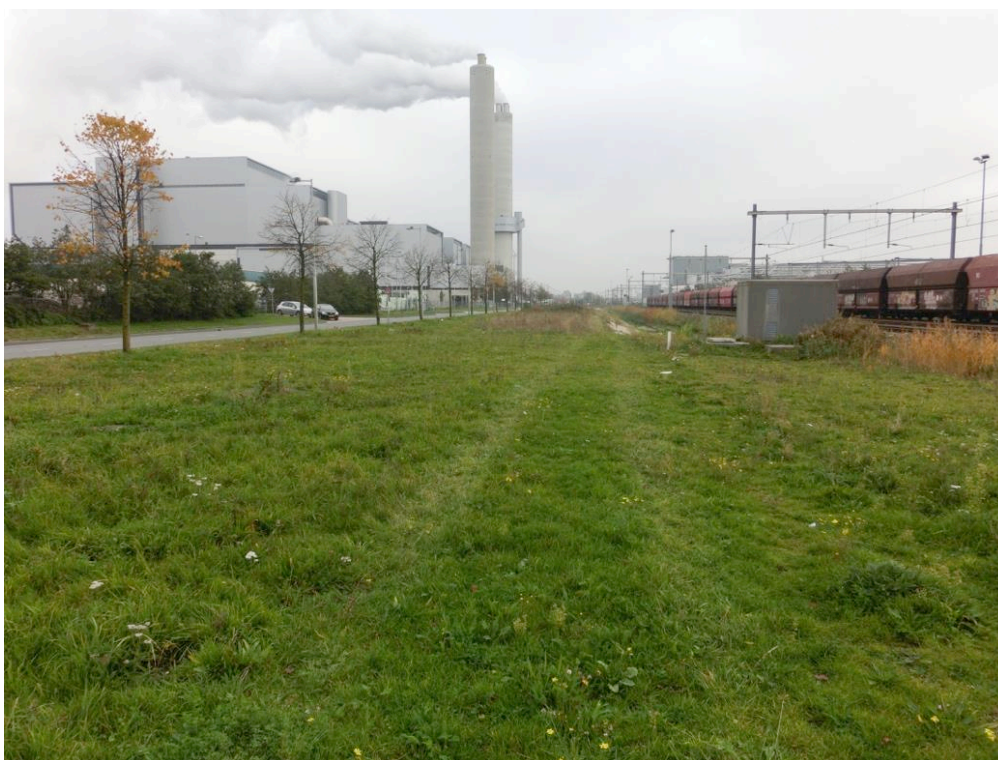
Figuur 3.2 Natuurstrook Aziëhavenweg, in verband met kabels en leidingen wordt het gras kort gehouden..
