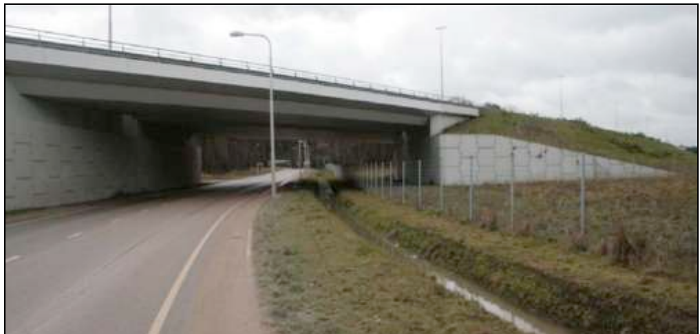
Figuur 5.4 Onderdoorgangen van viaducten kunnen worden geoptimaliseerd voor passage door fauna door een strook niet te verhard en deze te voorzien van bijvoorbeeld stobbenwallen; de doorgetrokken sloot is van belang voor watergebonden fauna.
