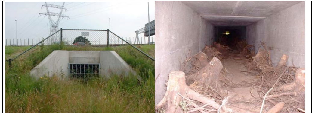
Figuur 2.4. Kleine faunatunnel onder de A1 bij Muiden, het talud rond de tunnel is verstevigd. Het traliewerk voorkomt het inkruipen van mensen; kleinere zoogdieren en amfibieën kunnen ongehinderd passeren. De binnenkant (90 x 70 cm) is voorzien van kleine stobben en grond.
