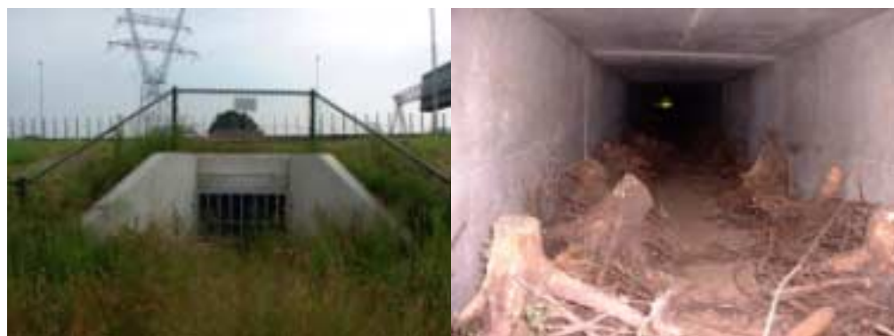
Kleine faunatunnel onder de A1 bij Muiden, het talud rond de tunnel is verstevigd. Het traliewerk voorkomt het inkruipen van mensen; kleinere zoogdieren en amfibieën kunnen ongehinderd passeren. De binnenkant is voorzien van kleine stobben.
