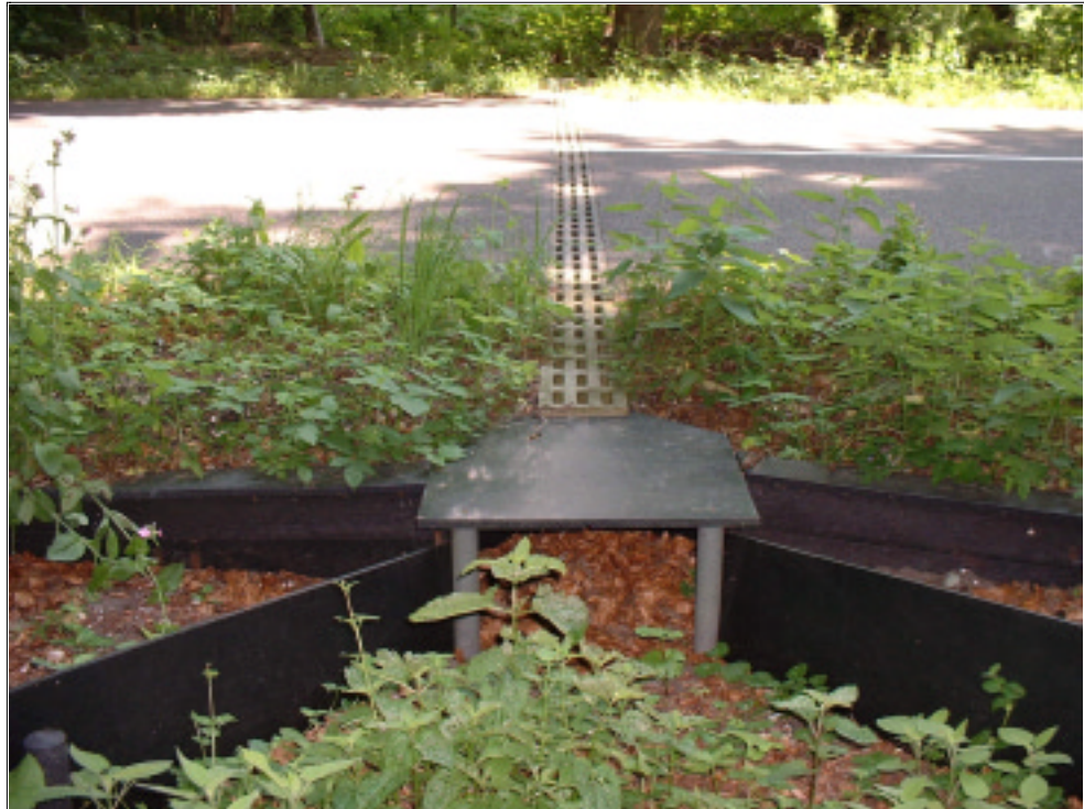
Figuur 5.4 Amfibieëntunnel bij Bergen.
